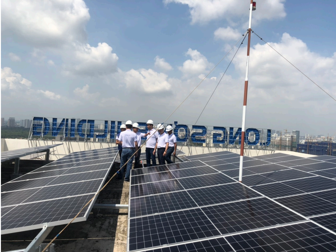
Lãnh đạo Công ty kiểm tra các hạng mục cuối cùng trước khi đóng điện.
